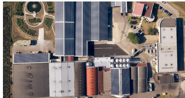
Panneaux photovoltaïques pour les toits des bâtiments de stockage de la cave coopérative de Buzet-sur-Baïse. - crédit photo : Les Vignerons de Buzet
